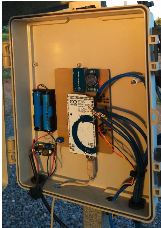
Figura 108: Instalação do sistema e conexão dos sensores dentro da caixa hermética.
