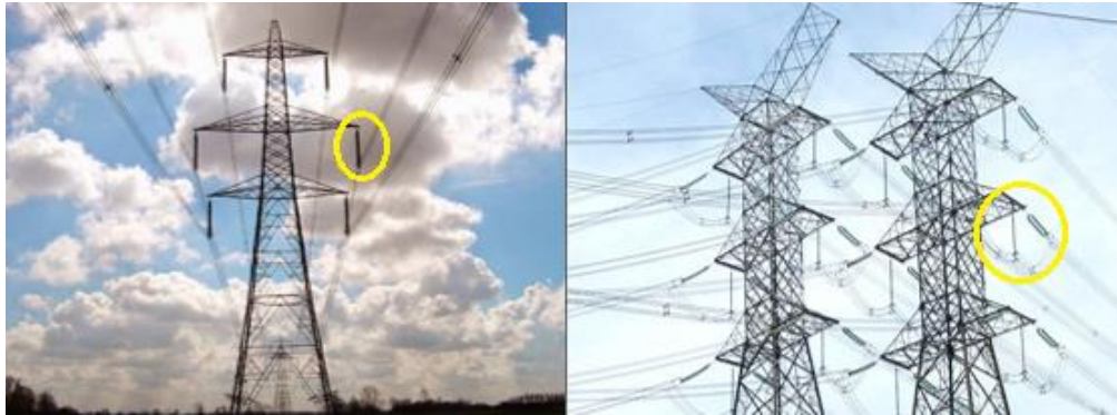
Figura 53- Estrutura de linhas de transmissão com destaque na localização dos isoladores.
