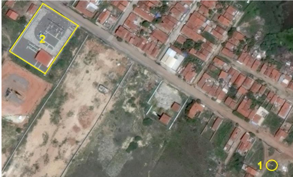
1 – Linha Inspeccionada 2 – Subestação Barrocas
