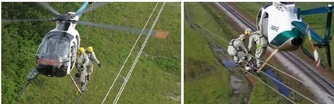
Figura 59- Inspeção aérea tripulada
