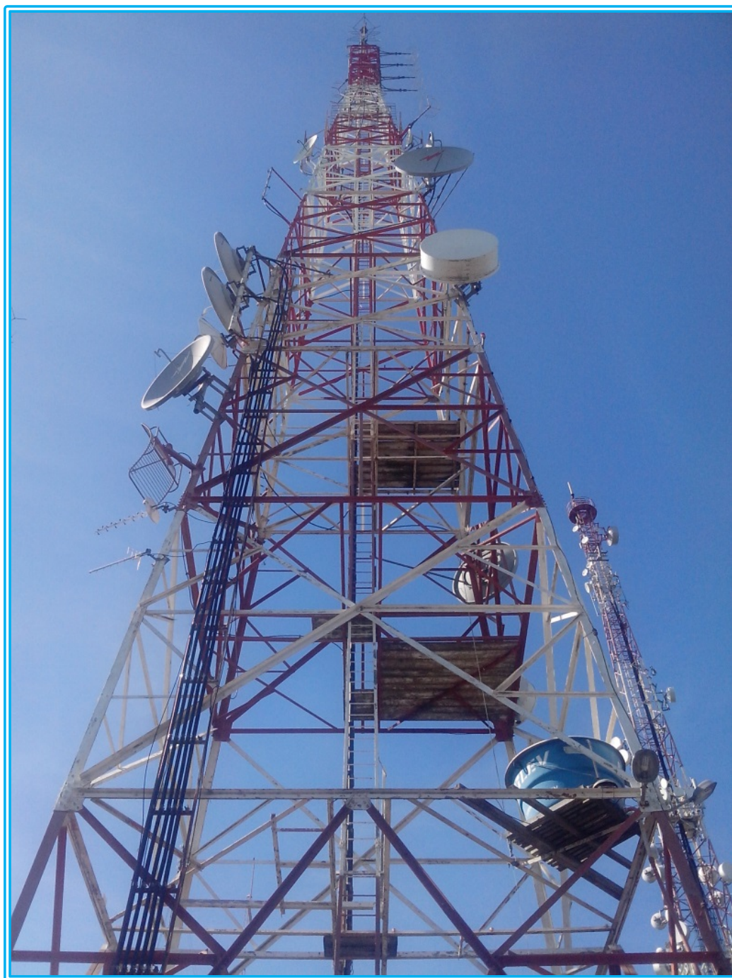
Figura 83 - Torre, antena e links com o estúdio Fonte: Autoria Própria
