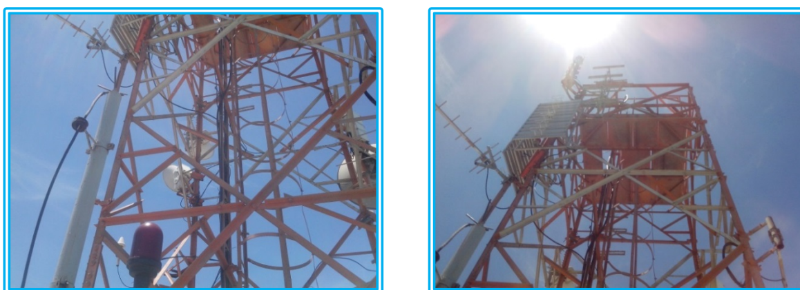
Figura 103 - Estrutura instalada em Guarapari Fonte: Autoria Própria
