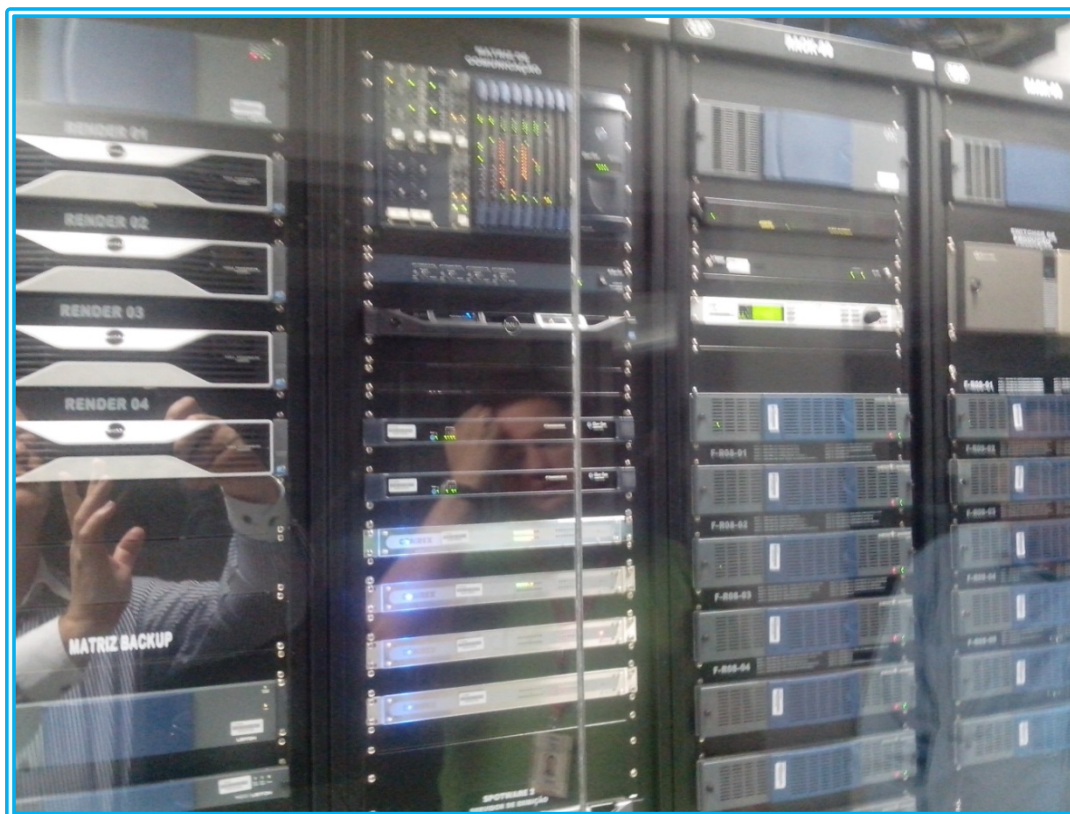
Figura 78 - Central técnica Fonte: Autoria Própria
