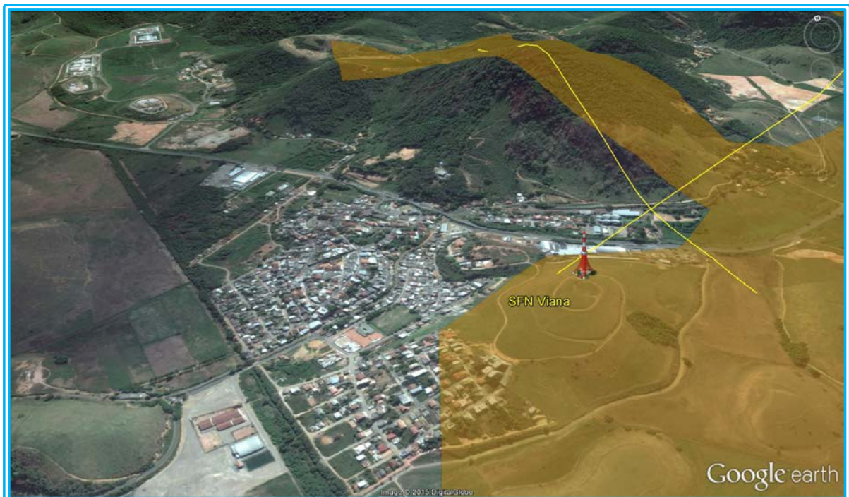
Figura 61 - Obstrução de Vitória à Viana Fonte: Autoria Própria
