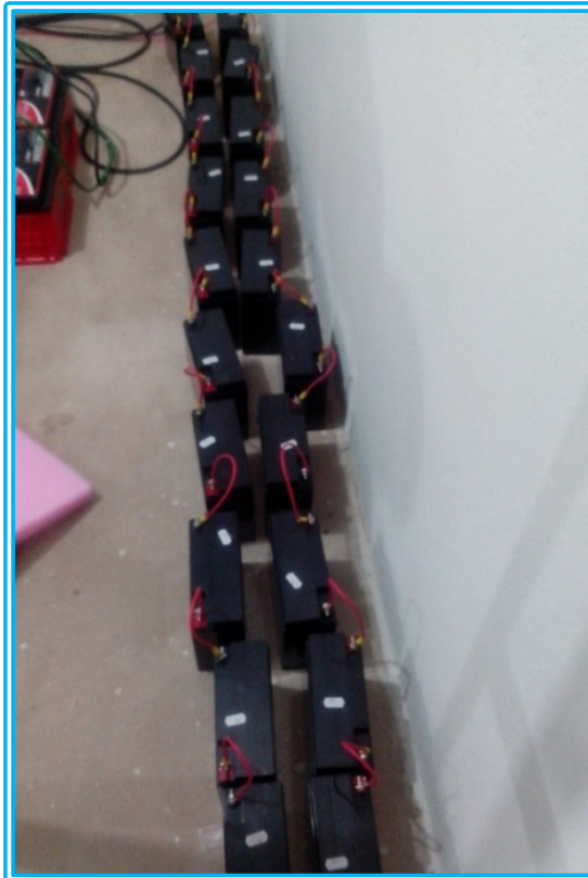
Figura 108 - Estação Viana - montagem dos equipamentos Fonte: Autoria Própria
