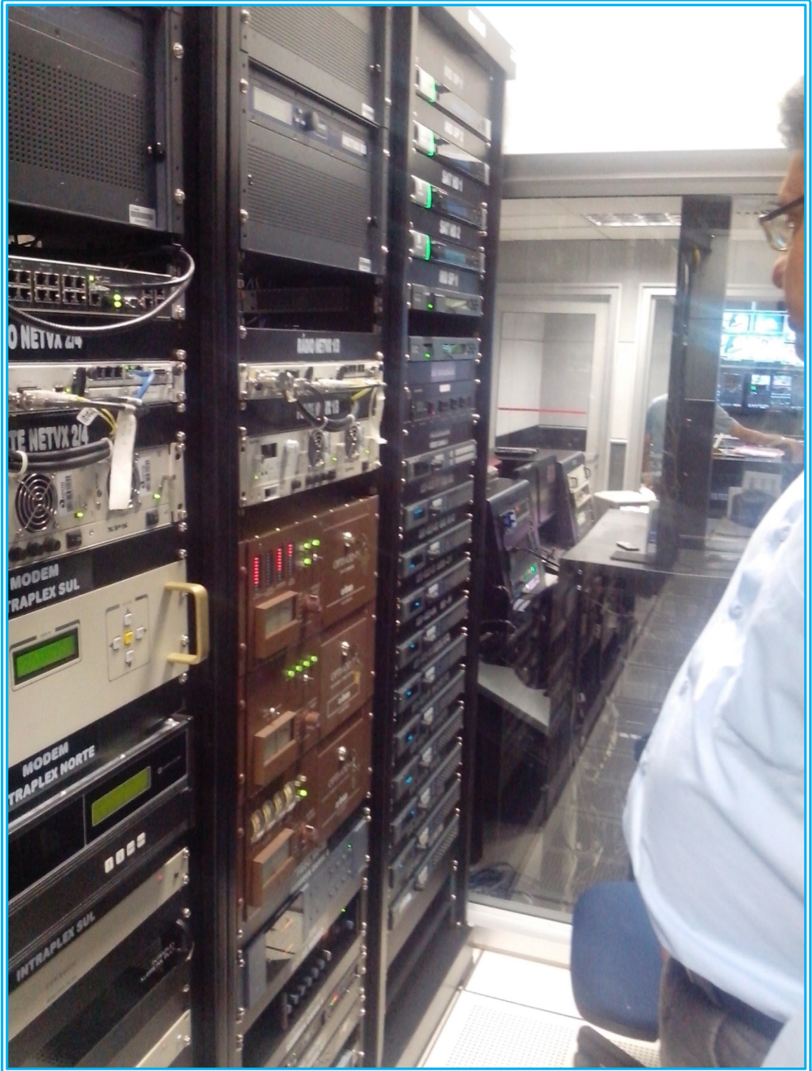
Figura 77 - Central técnica Fonte: Autoria Própria
