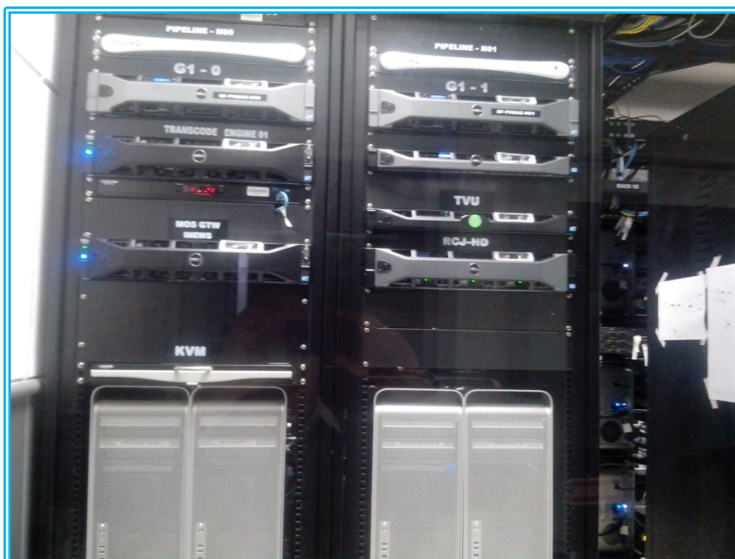
Figura 79 - Central técnica Fonte: Autoria Própria
