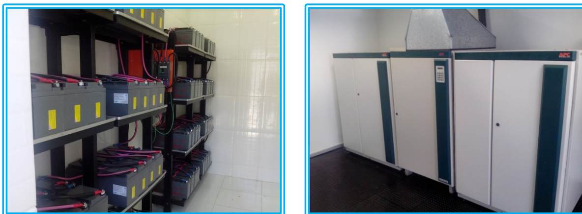
Figura 88 - Site Tx principal TV Gazeta - Vitória Fonte: Autoria Própria
