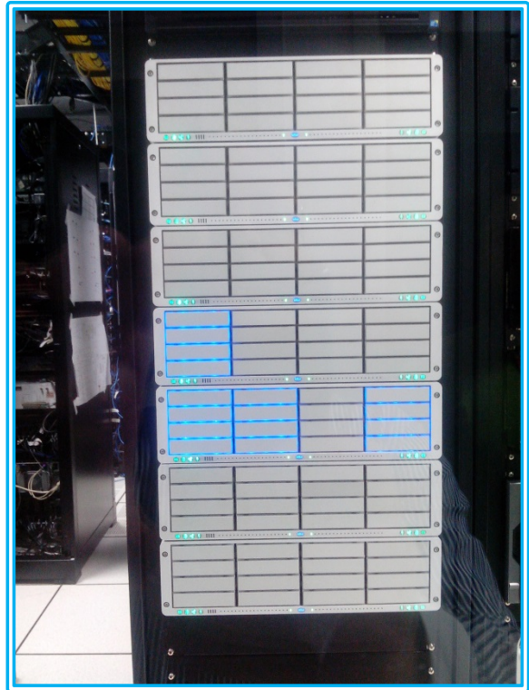
Figura 76 - Central técnica Fonte: Autoria Própria
