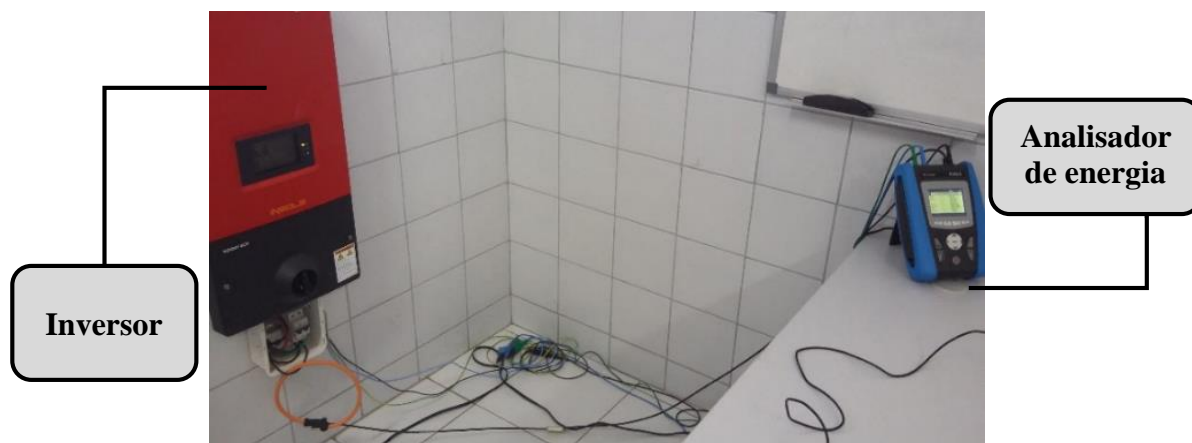
Figura 25 – Medição dos parâmetros elétricos de geração do SFCR na saída do inversor.
