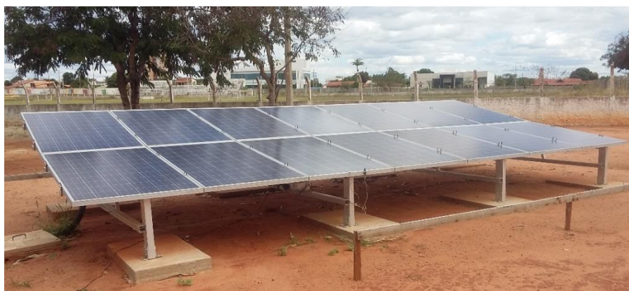
Figura 18 - Módulos fotovoltaicos YL245P - 29b, Yingli Solar . Fonte: Autoria própria, 2015
