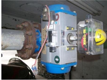
**Figura 29 – Válvula eletropneumática para a manobra de abastecimento de água do poço para a caixa dos escritórios.**
