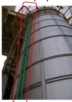
**Figura 15 – Tubulações de água de abastecimento e retorno dos bicos pulverizadores da torre de refrigeração do forno rotativo.**
