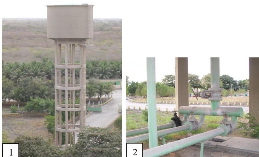
**Figura 17 – (1) Caixa d’água geral, e (2) Tubulações de abastecimento de água para os processos.
