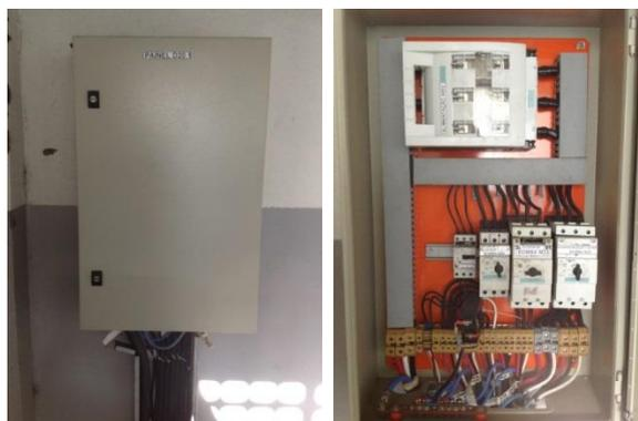
**Figura 24 – Painel D20.1: Acionamento dos *drivers* eletrônicos.**
