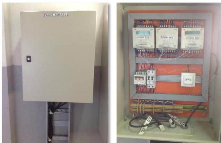
**Figura 22 – Painei *Smart 2.2* para medição de energia elétrica das bombas M30, M26 e M22.**
