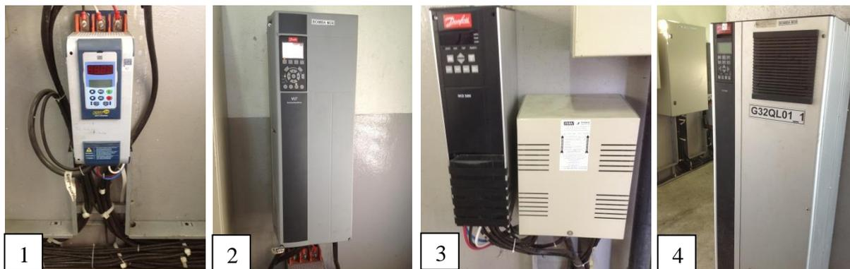
**Figura 23 – Em (1) e (2) *Soft-Start Weg* e Inversor de Frequência *Danfoss* para a bomba M26, e em (3) e (4) *Soft-Start* e Inversor de Frequência, ambos *Danfoss* para bomba M30.**
