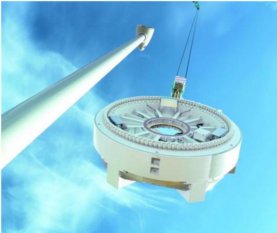
Figura 8 -Rotor do Gerador Síncrono para Aplicação em Sistemas Eólicos
